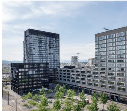
SBB Bürogebäude Westlink, Zürich
