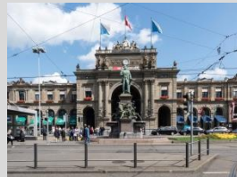
Zürich HB Südtrakt Sanierung
