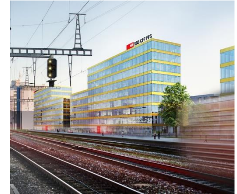
SBB Bürogebäude Parc du Simplon, Renens
