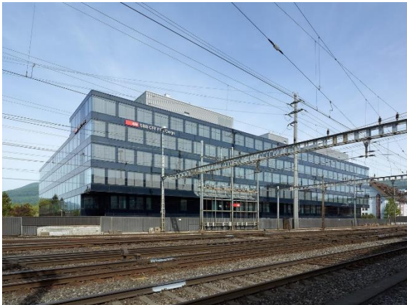
SBB Aarepark, Olten SBB Cargo und SBB Infrastruktur
