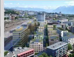
Baubeginn Parc du Simplon, Renens
