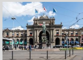
Aile sud Zurich HB Assainissement
