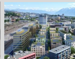
Début des travaux Renens Parc du Simplon
