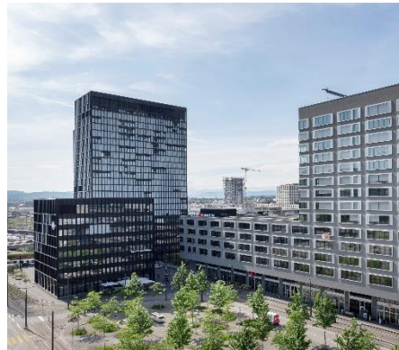
Immeubles de bureaux CFF Westlink, Zurich
