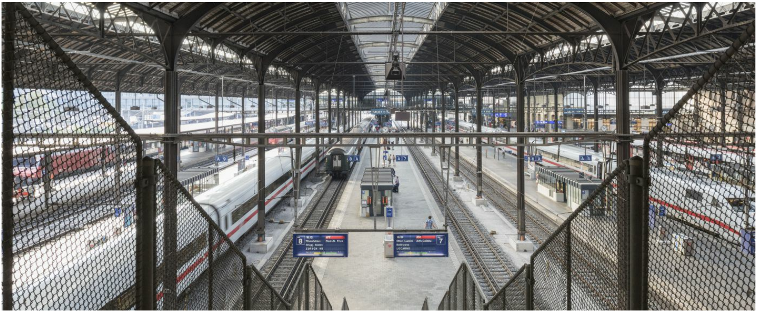
Die Sanierung der Perronhallen sorgt für eine 60 Jahre längere Lebenszeit.
