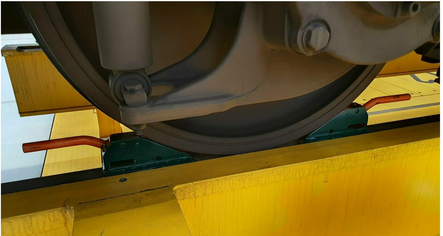
[12:11] Ryter Manola (KOM-IGK-BER1) Deux cales de roue utilisées sur l'installation de levage enterrée.
